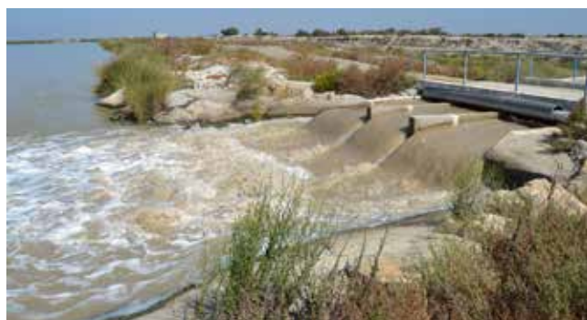
Bombeo solar en Trebujena
